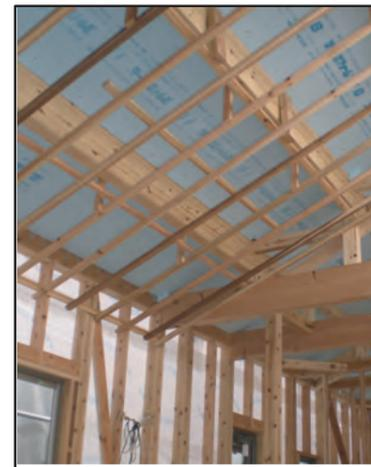
屋根の断熱:ポリスチレンフォーム40mmを根太下に施工する事で空気層を確保し、空気が流れるようになっています。
